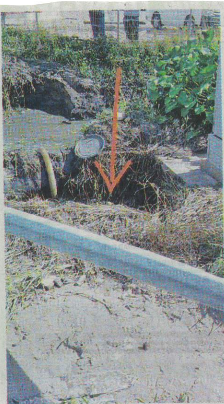
维修水管位置。(相片取自纳闽水务局脸书)
